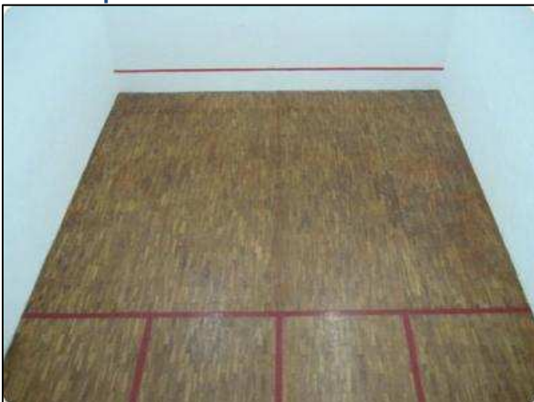
Detalle de parquets inadecuados para la competición por su oscuridad y capa de barniz.
