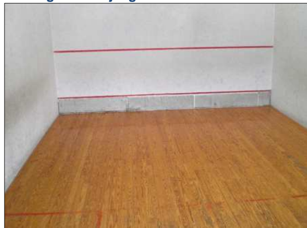
Detalle de parquets inadecuados para la competición por su oscuridad y capa de barniz.
